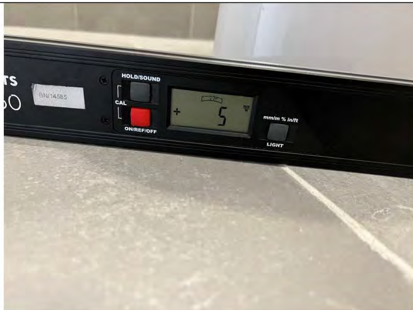
Фото №31. Измерение уровня напольного покрытия в санузле.
