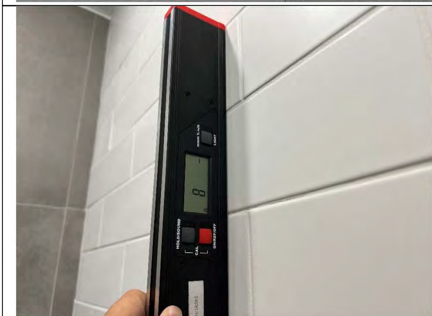
Фото №18. Измерение уровня стен в ванной комнате.
