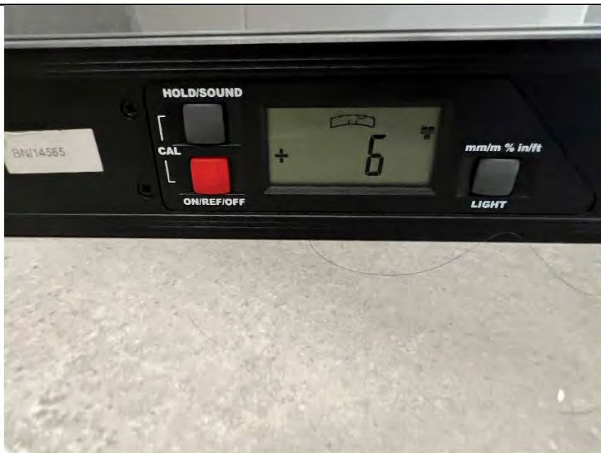
Фото №30. Измерение уровня напольного покрытия в ванной комнате.
