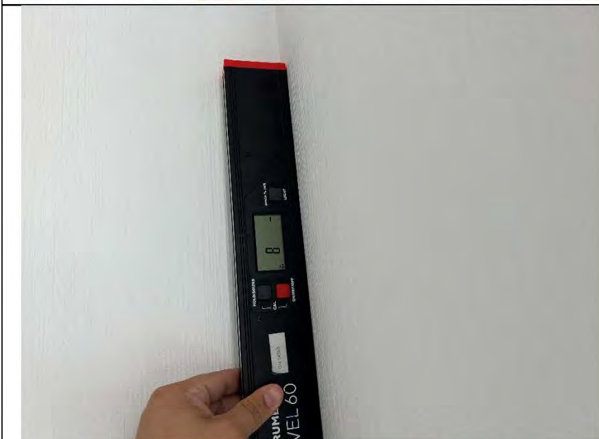
Фото №14. Измерение уровня стен в кухне.
