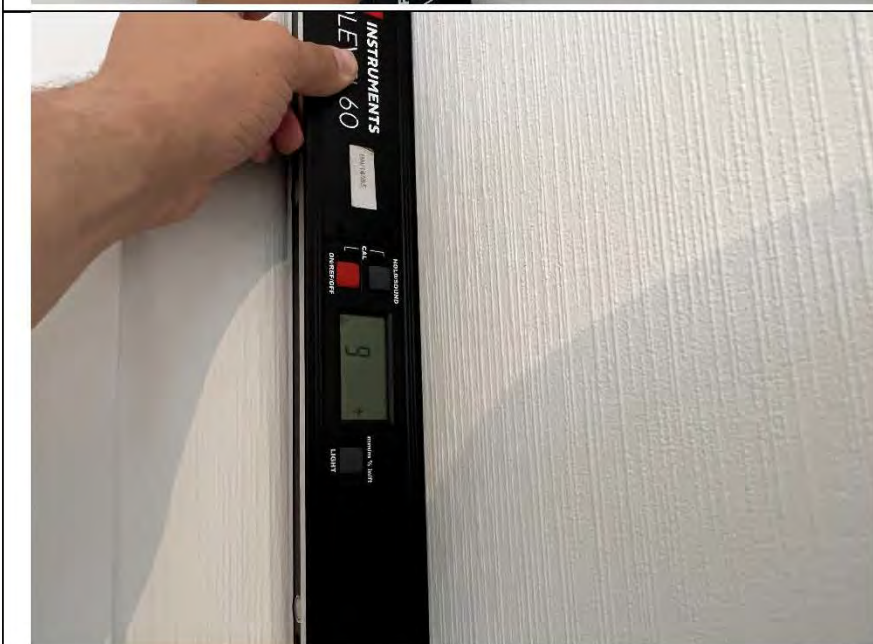
Фото №15. Измерение уровня стен в гостиной.
