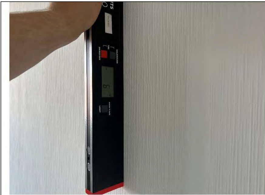
Фото №13. Измерение уровня стен в спальне.
